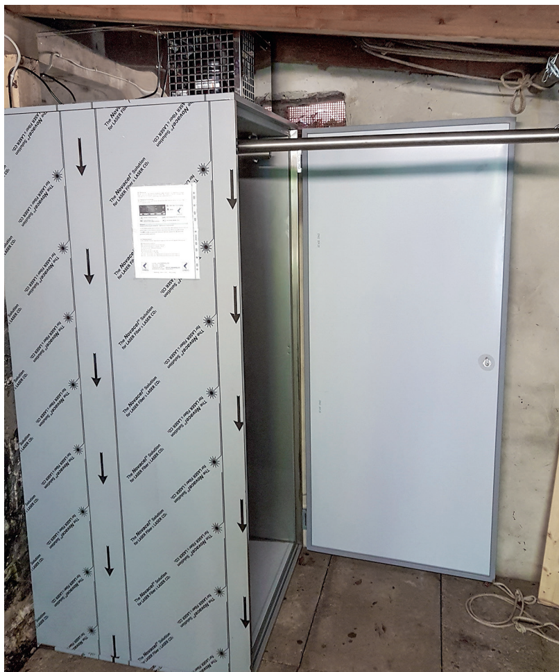
Vor Ort lässt sich die Zelle (hier noch in Schutzfolie) im Nu aufbauen und ausrichten – achten Sie darauf, ob man das Aggregat oben montieren kann.
